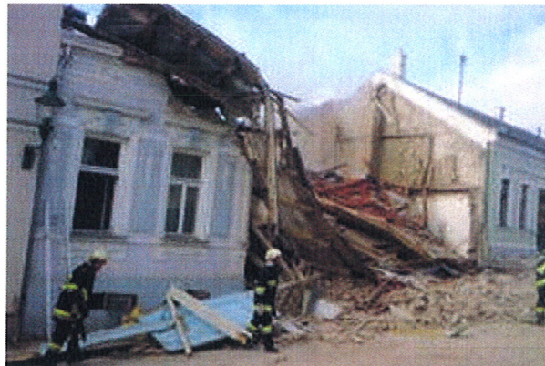
Das zerstörte Haus in Hagenbrunn
